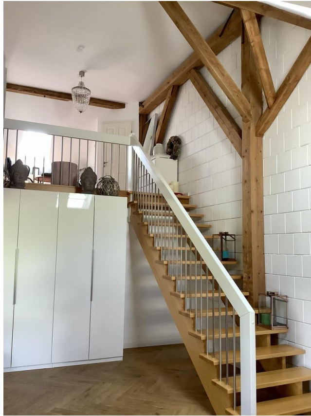
Treppe mit Empore
