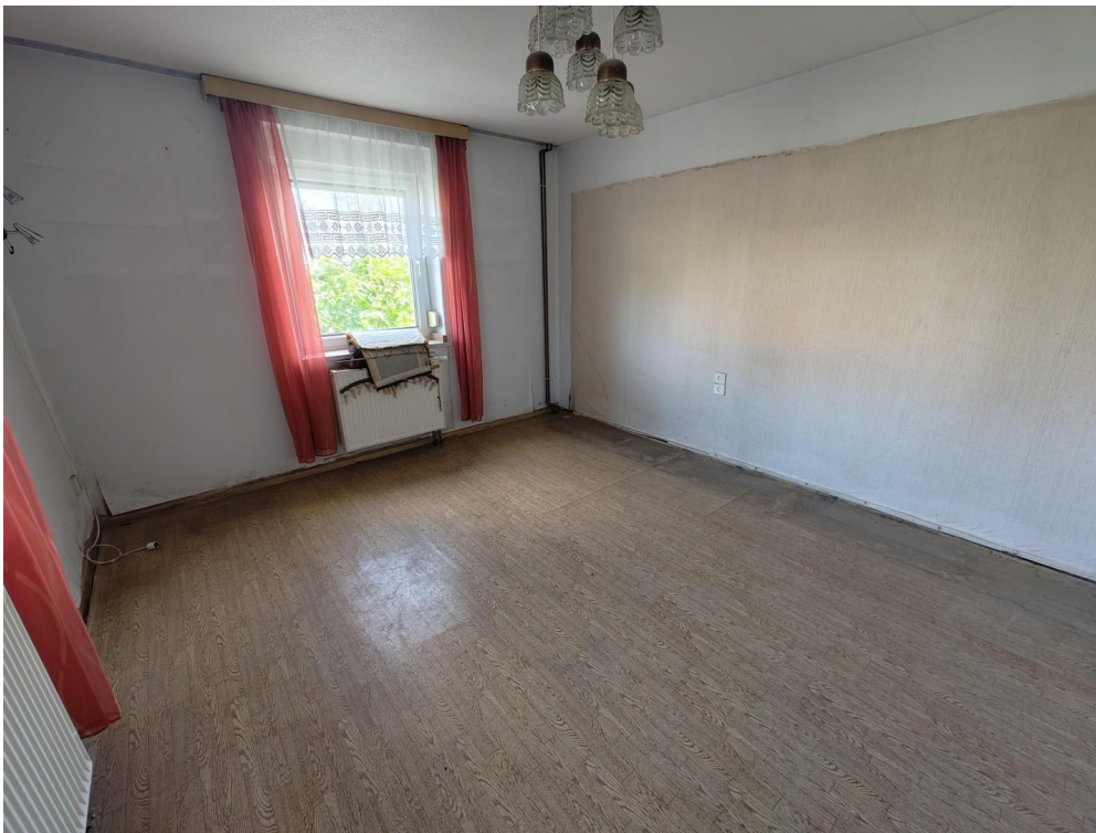
Raum im Erdgeschoss
