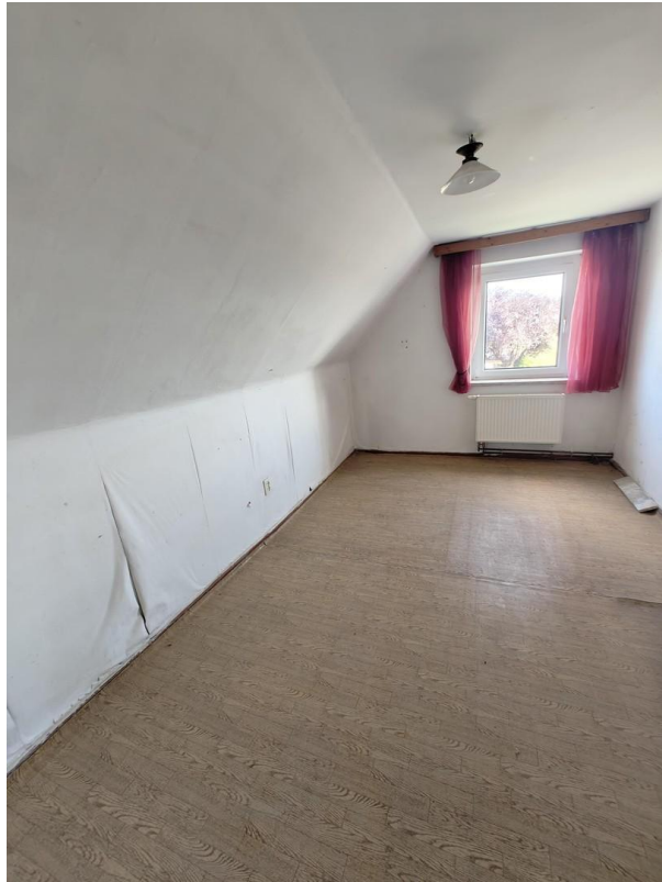
Raum im Obergeschoss
