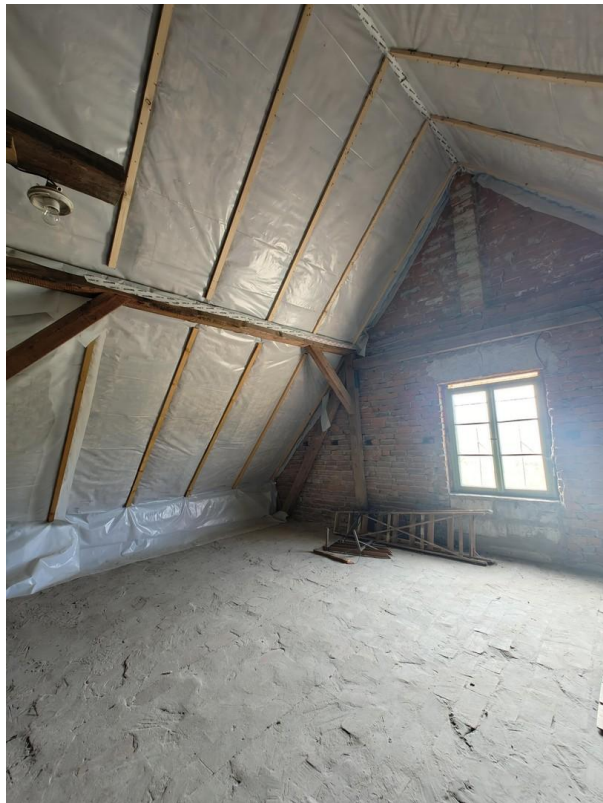
Nicht ausgebauter Teil des OG
