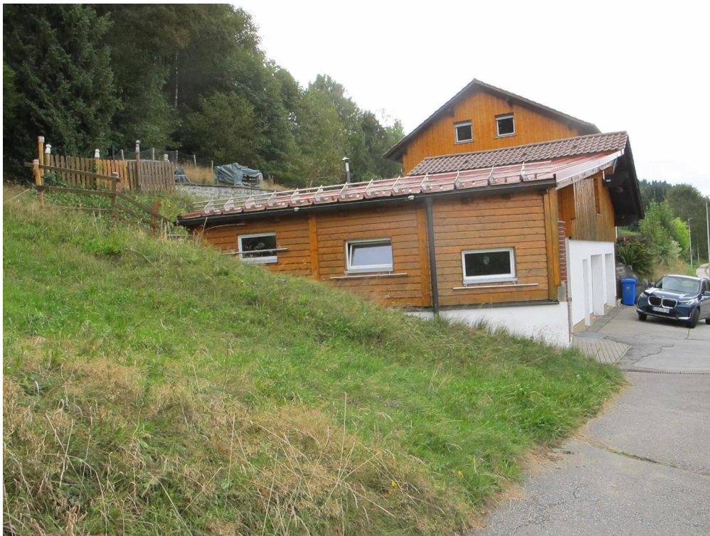
Seitenansicht mit Garagen
