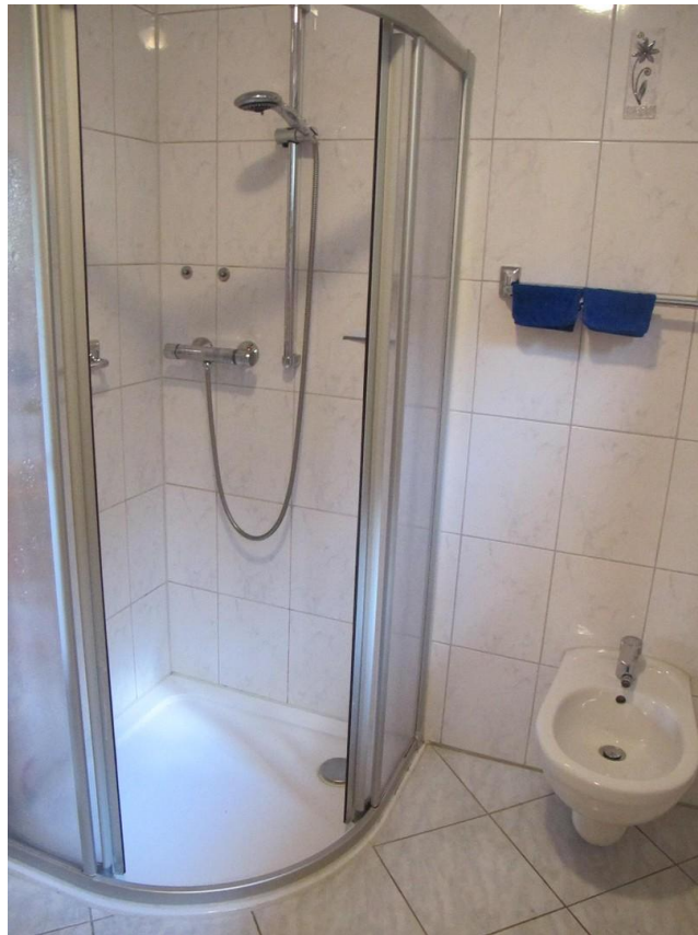
Dusche neu installiert
