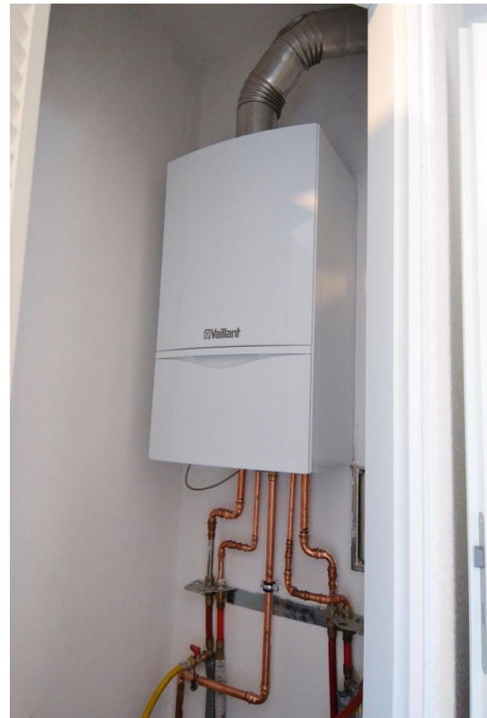
Gasetagenheizung
