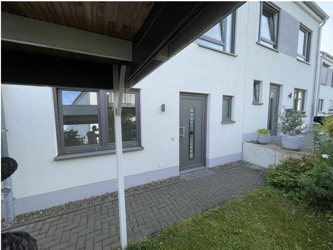
Hausrückseite mit Eingangstür
