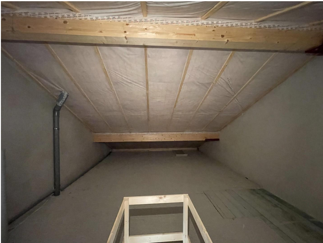
Großer Dachspeicher (~75 m 2 )
