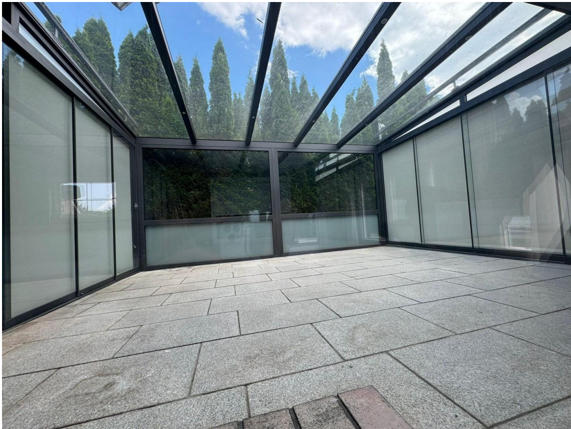
Wintergarten mit Downlight
