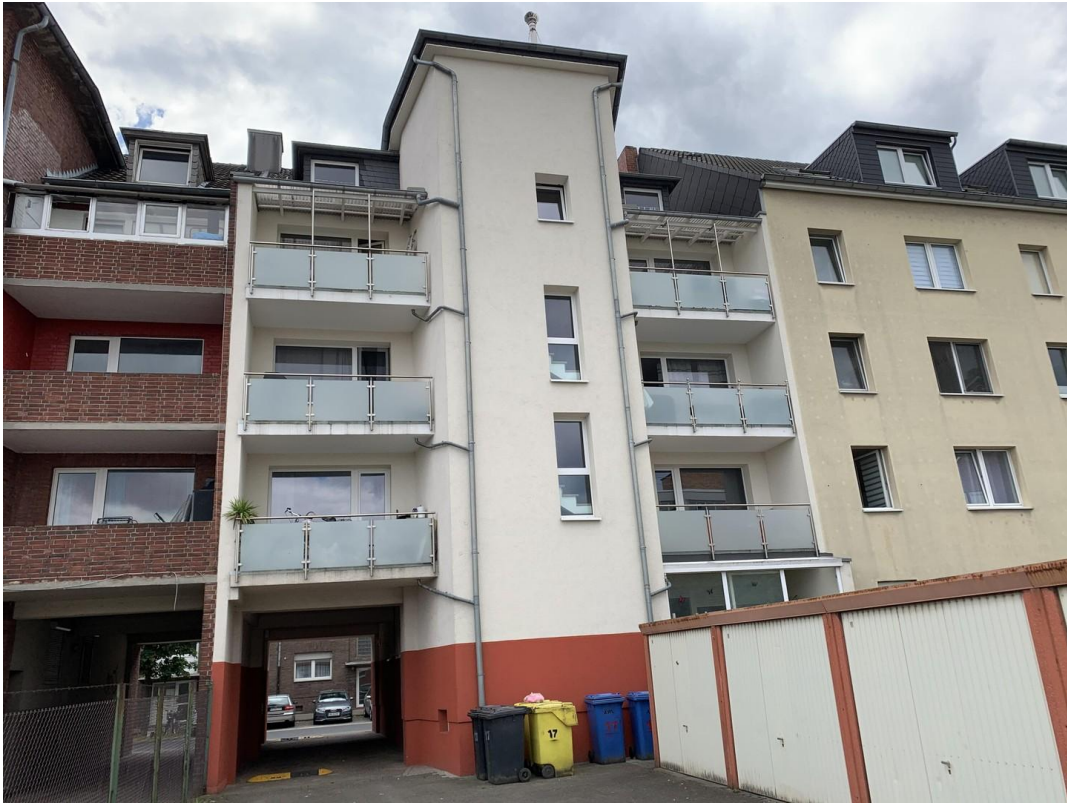
Wohngebäude - Ansicht Nord
