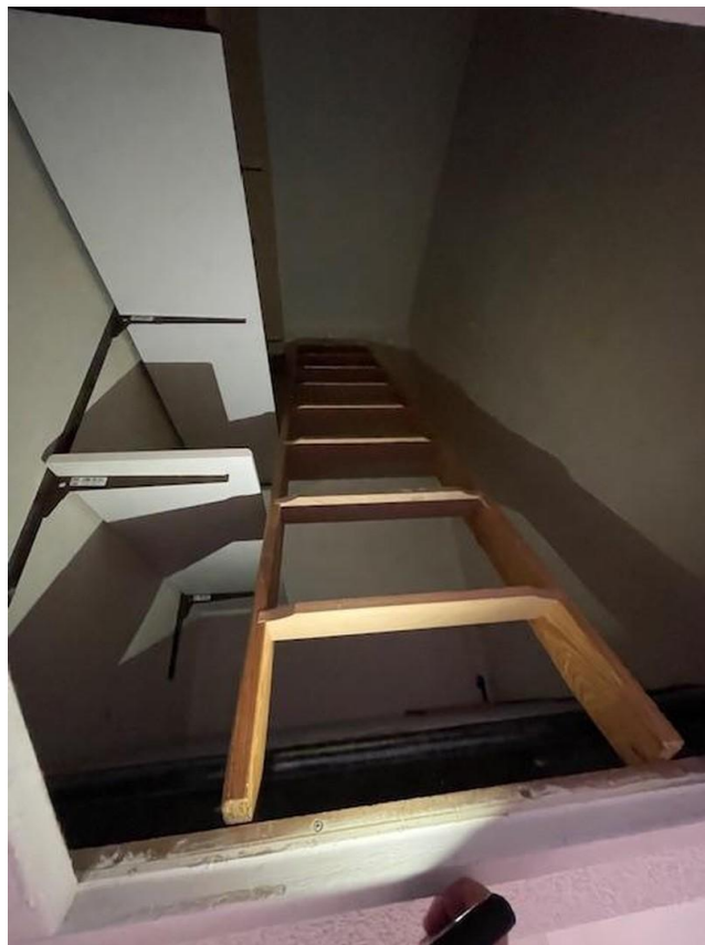
Stauraum im Spitzboden
