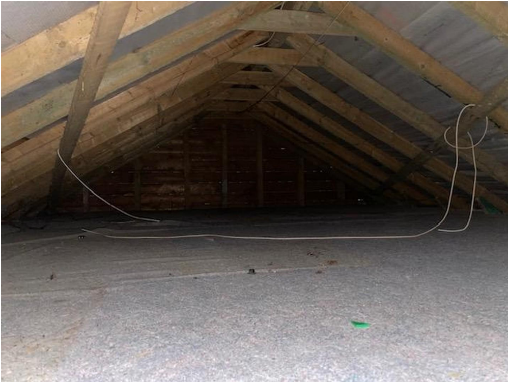
Stauraum im Spitzboden
