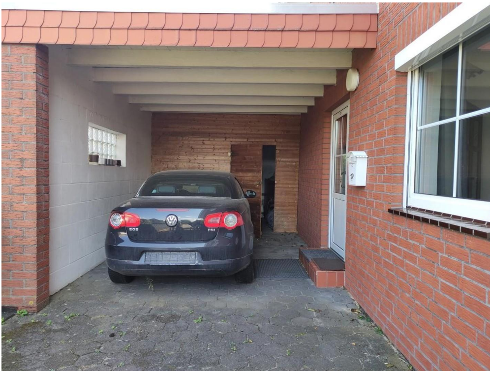
Carport mit hinterem Schuppen
