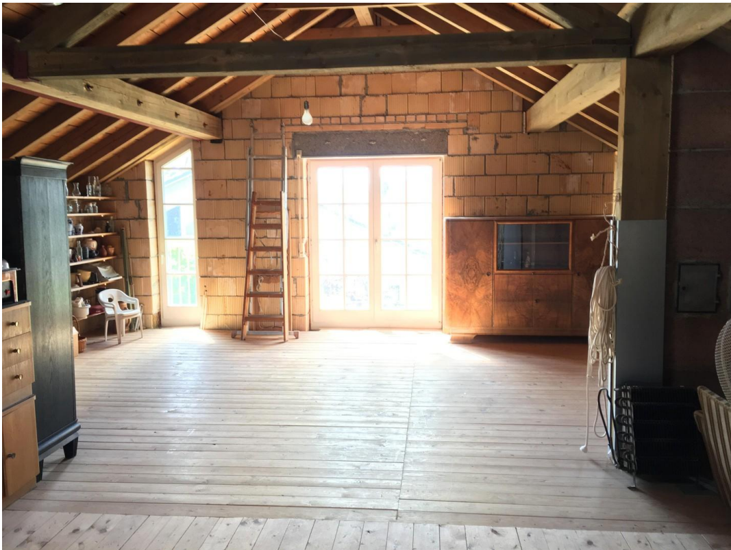
DG zum Ausbau vorbereitet
