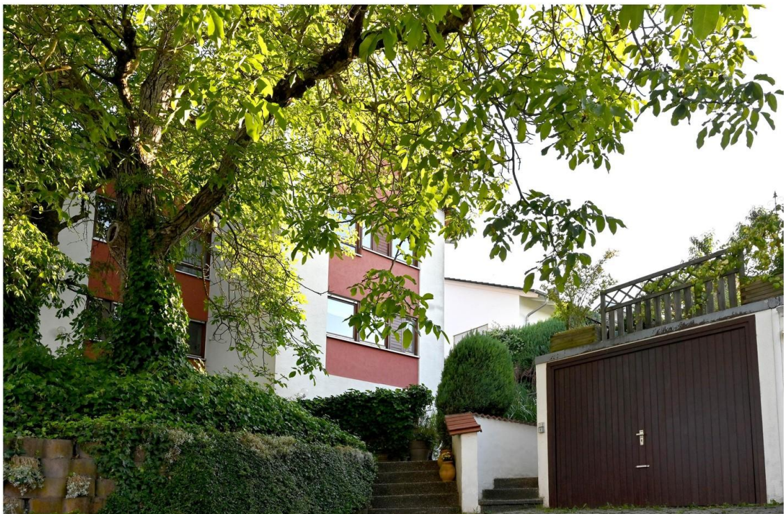
Hausansicht von Norden | Garage
