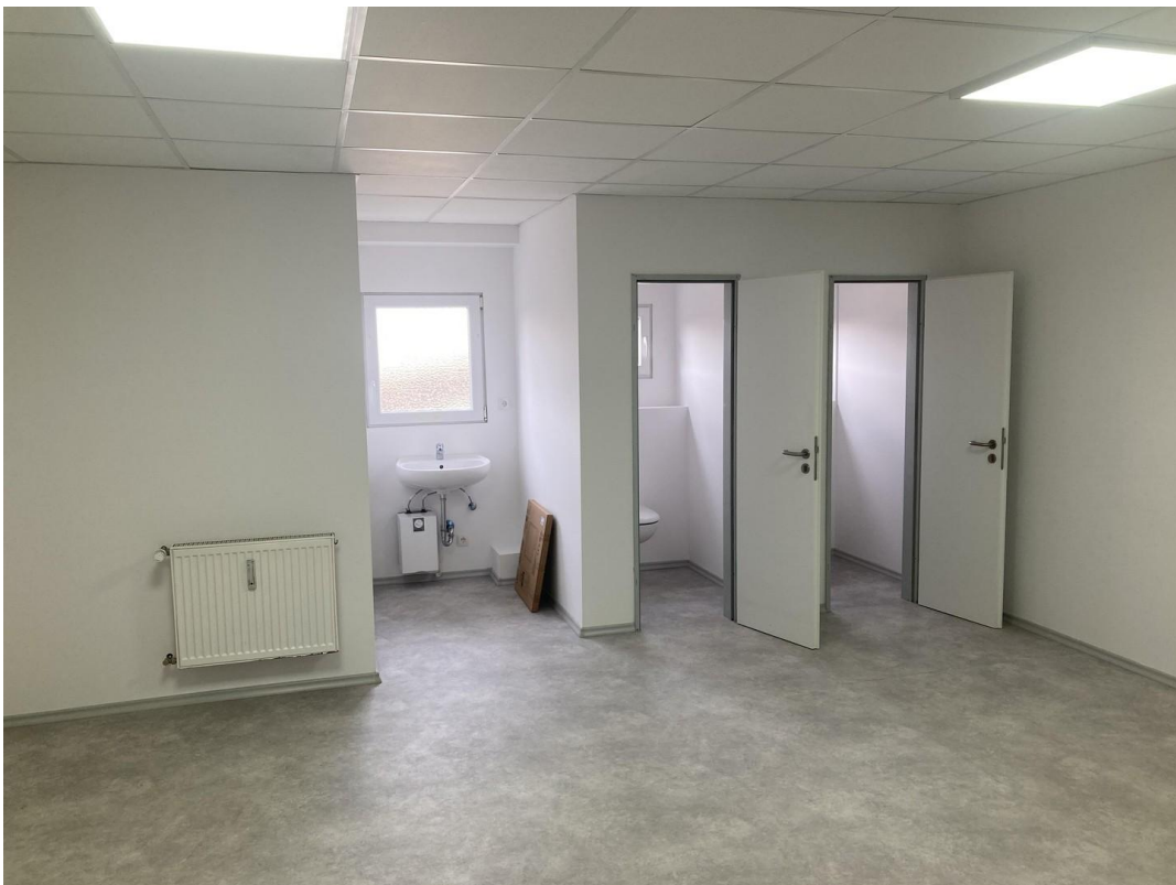
Kleiner Raum mit Toiletten
