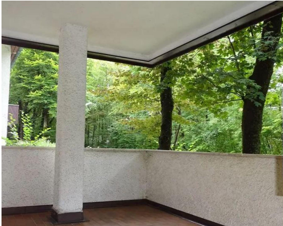
Terrasse zur Straße
