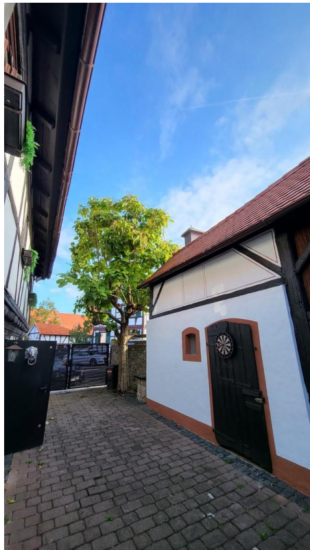
Wasch- und Heizraum
