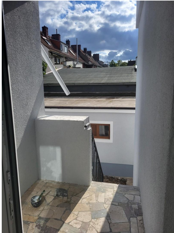
Balkon mit Treppe zur Garage
