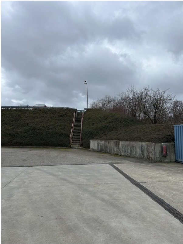
Aufgang Park- und Lagerfläche
