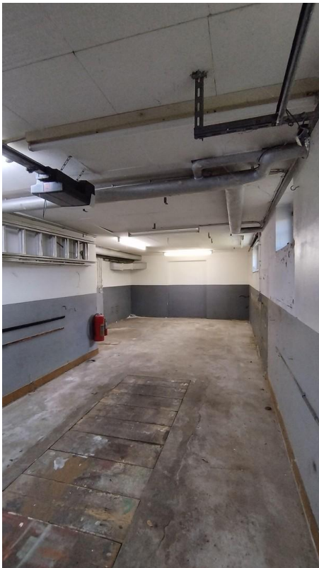
Garage mit Grube
