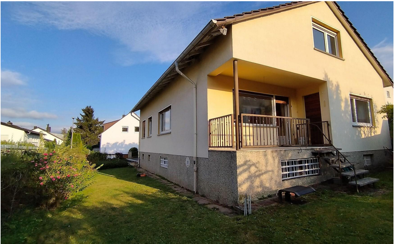
Gartenseit mit Balkon-Treppe
