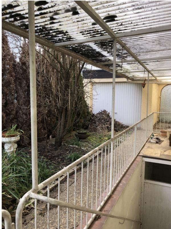
Überdachung zur Garage
