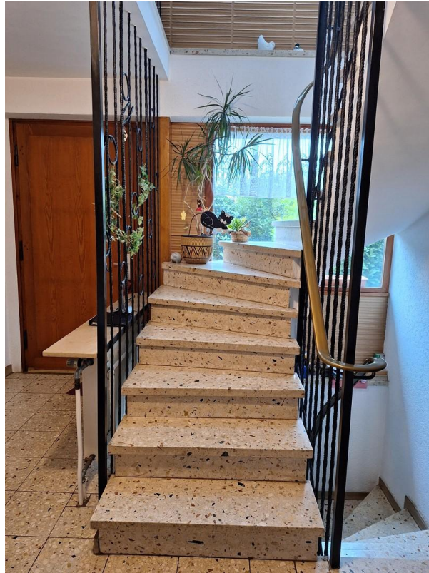
Treppenaufgang ins 1. OG
