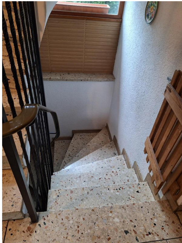
Treppenabgang ins UG
