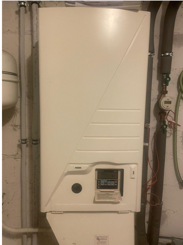
Wärmepumpe Inneneinheit
