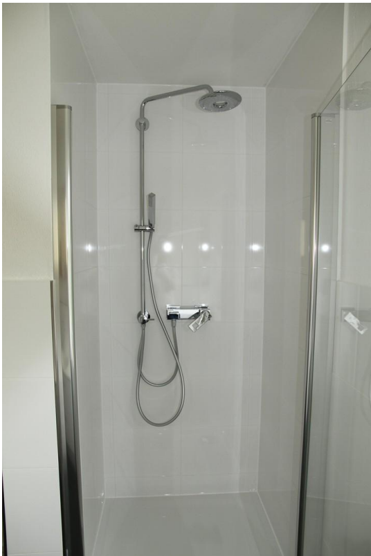
Dusche großes Bad
