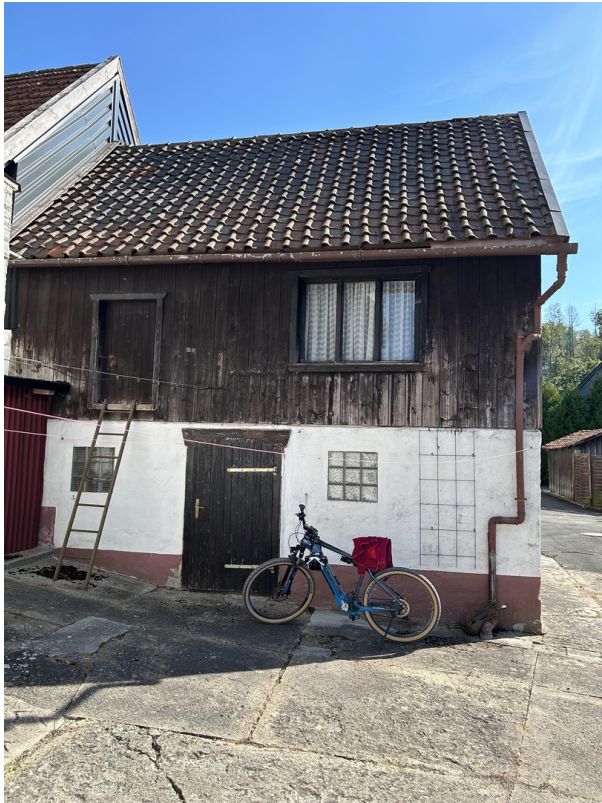
Scheune mit Werkstatt
