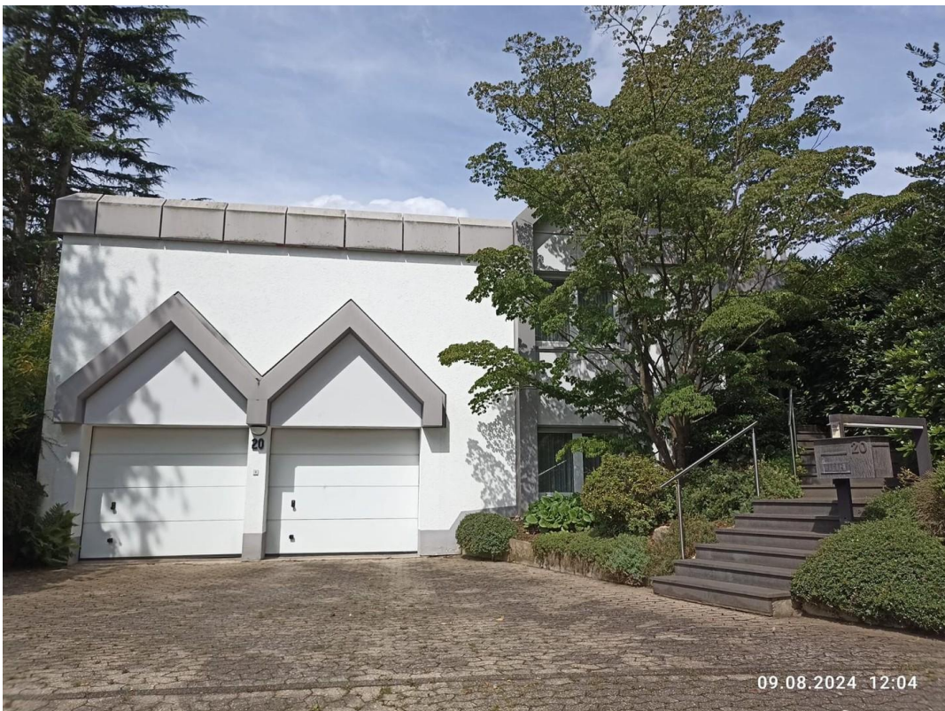
Hausfront mit Eingangstreppe
