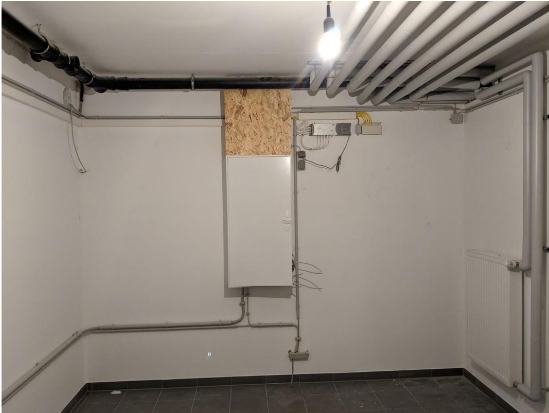
Technikraum und Wäsche - UG
