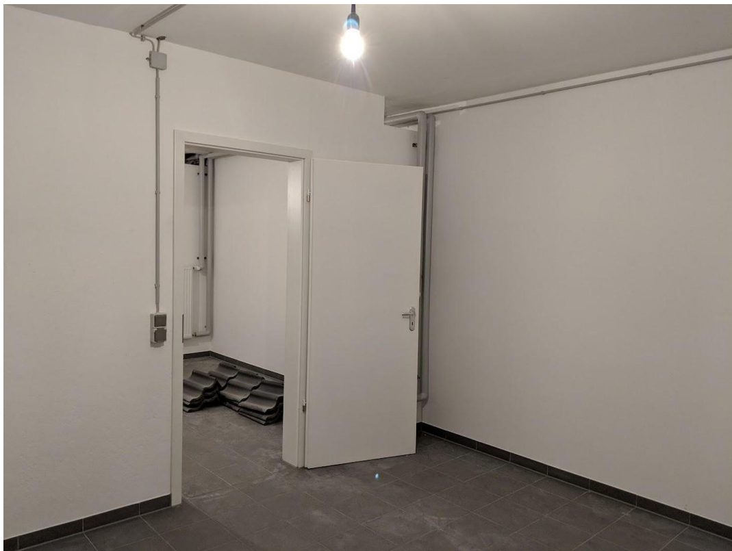
Stauraum und Kellerraum - UG
