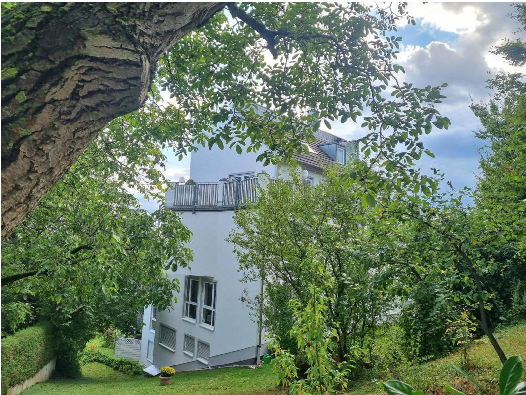
Außenbereich von Straßenseite
