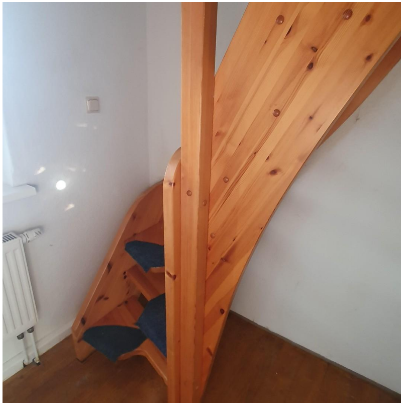
Treppe zum DG
