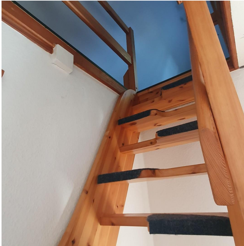
Treppe zum DG
