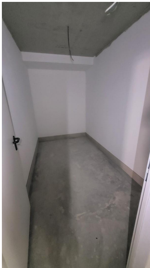
Abstellraum im UG
