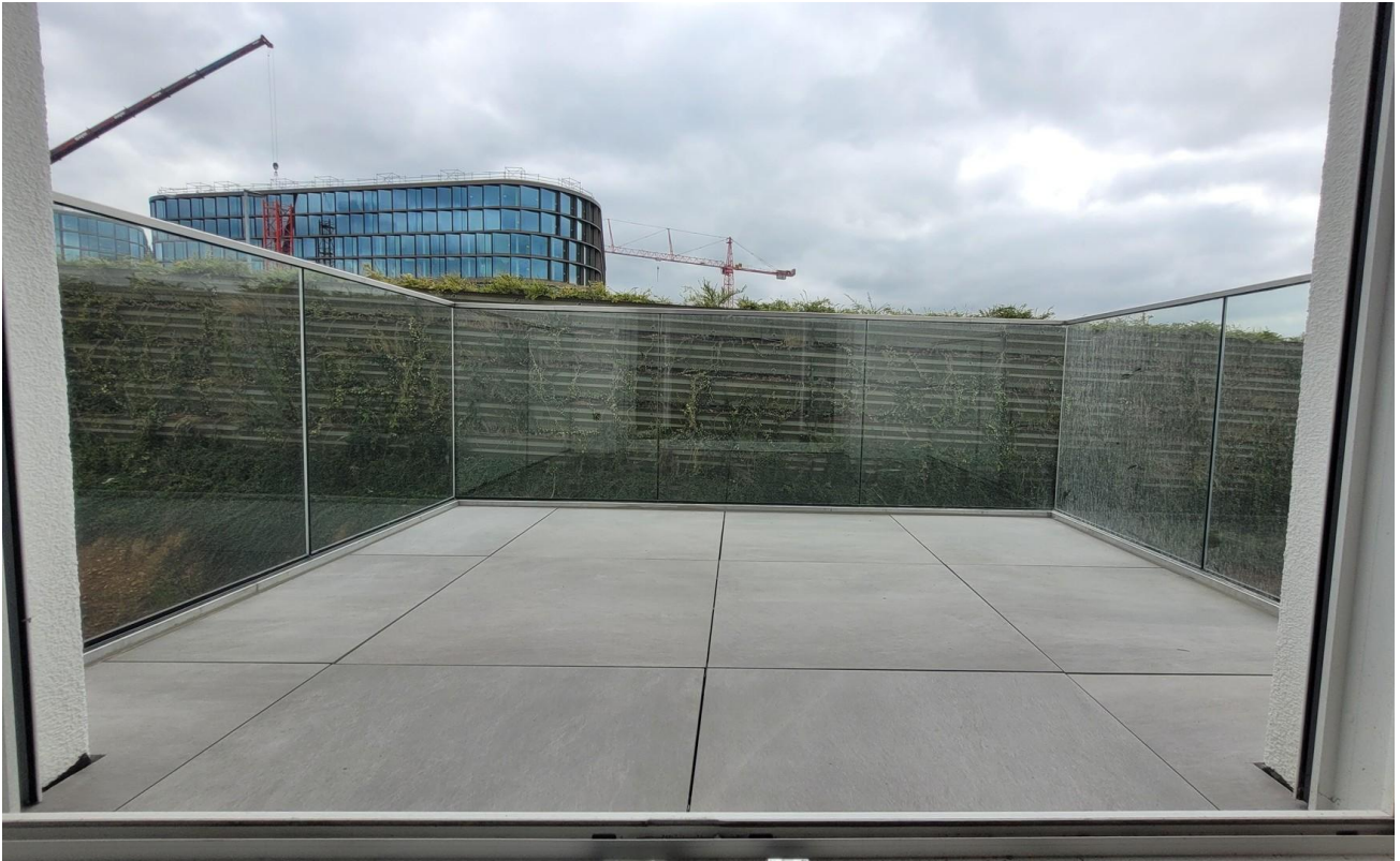
Balkon im OG
