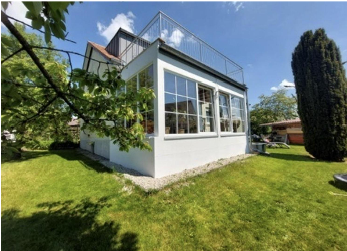
Ansicht aus Richtung Süden
