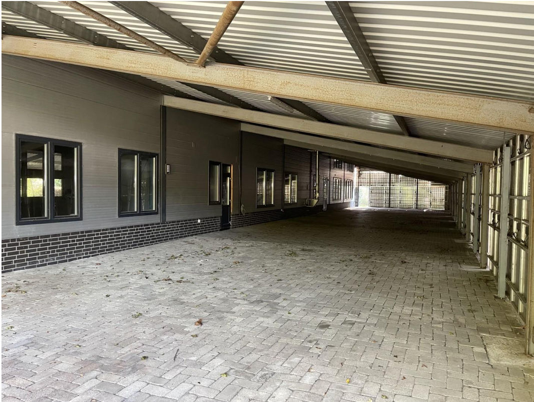
Halle Überdachung links
