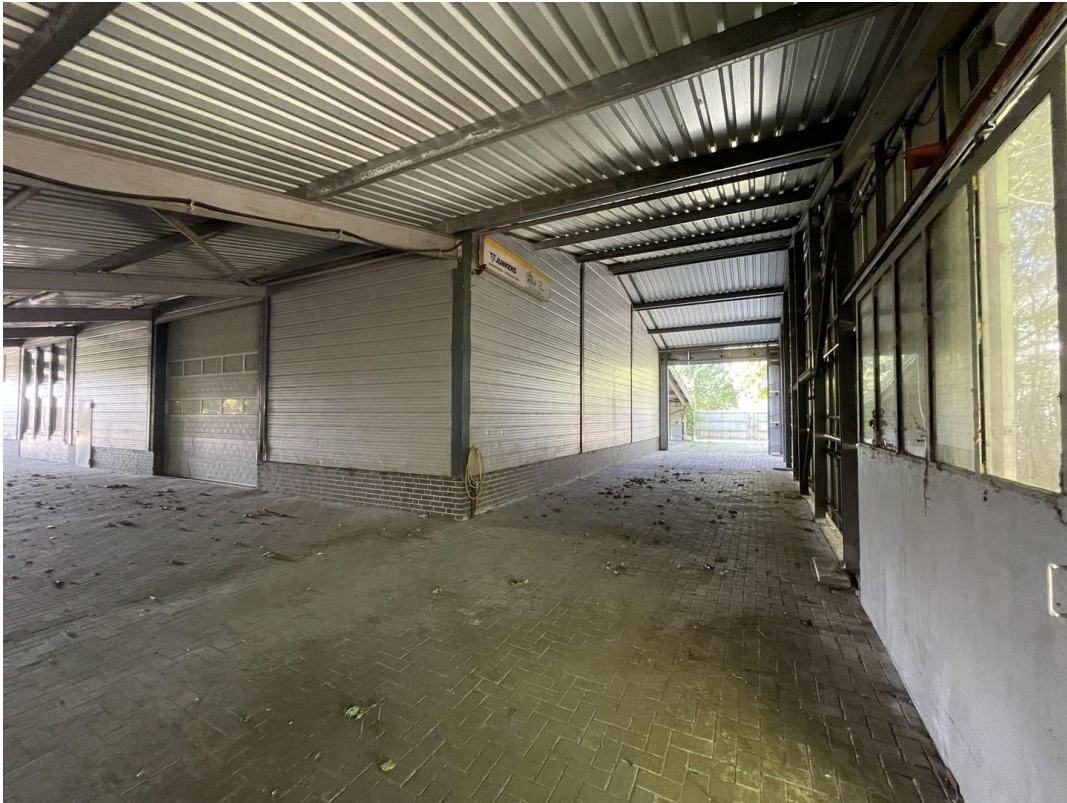
Halle Überdachung hinten
