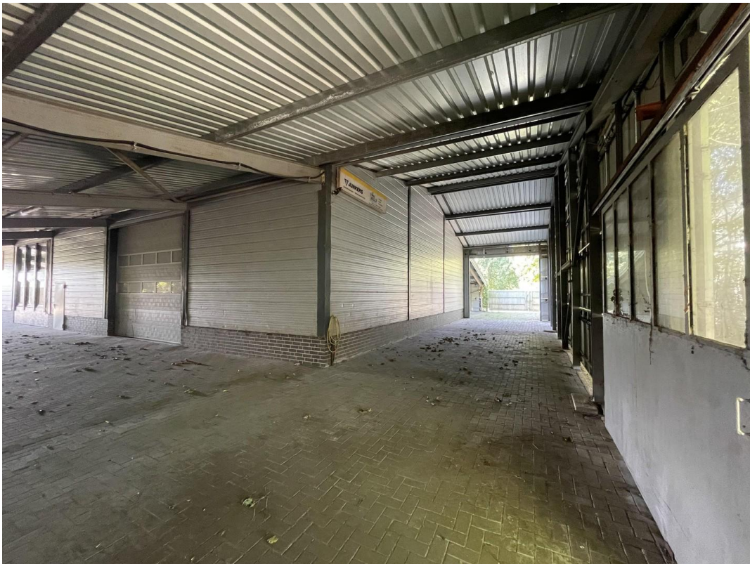
Halle Überdachung hinten
