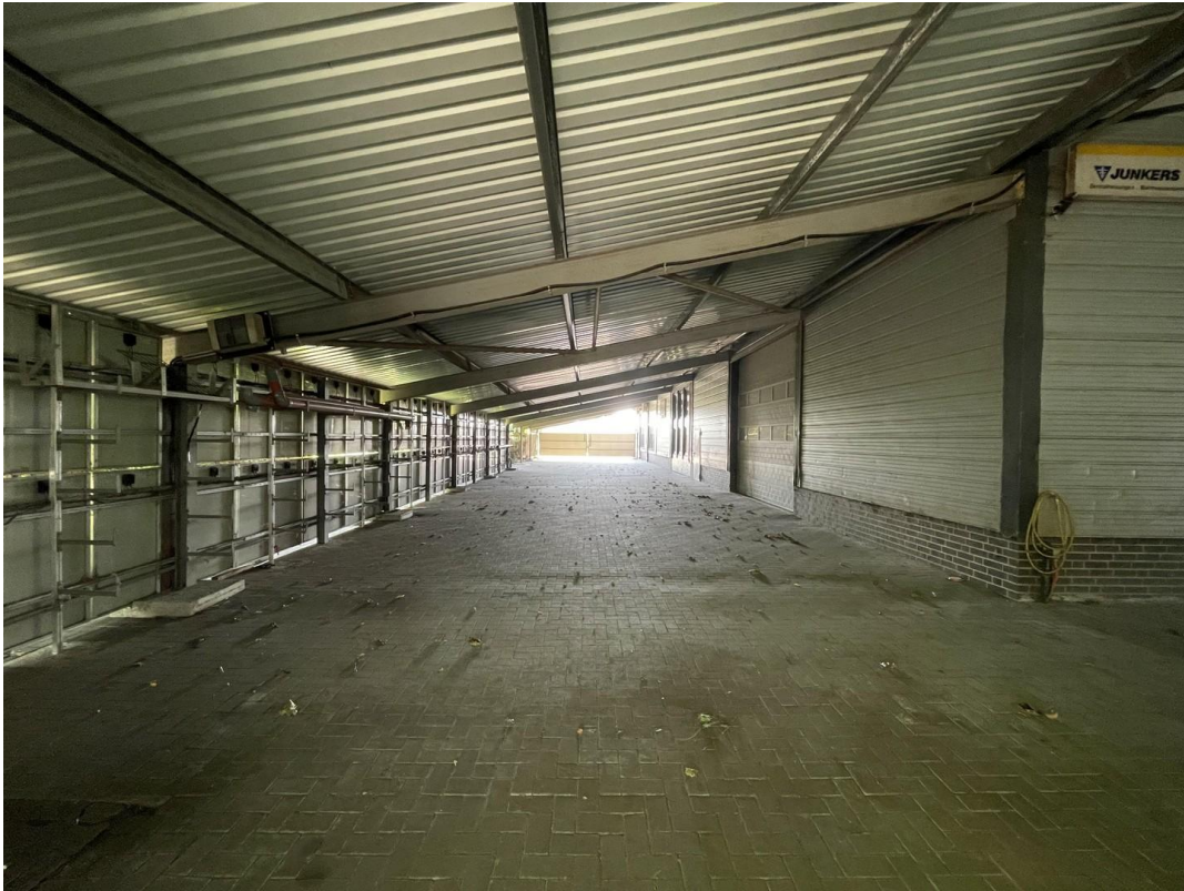
Halle Überdachung rechts
