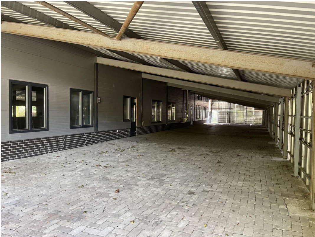
Halle Überdachung links
