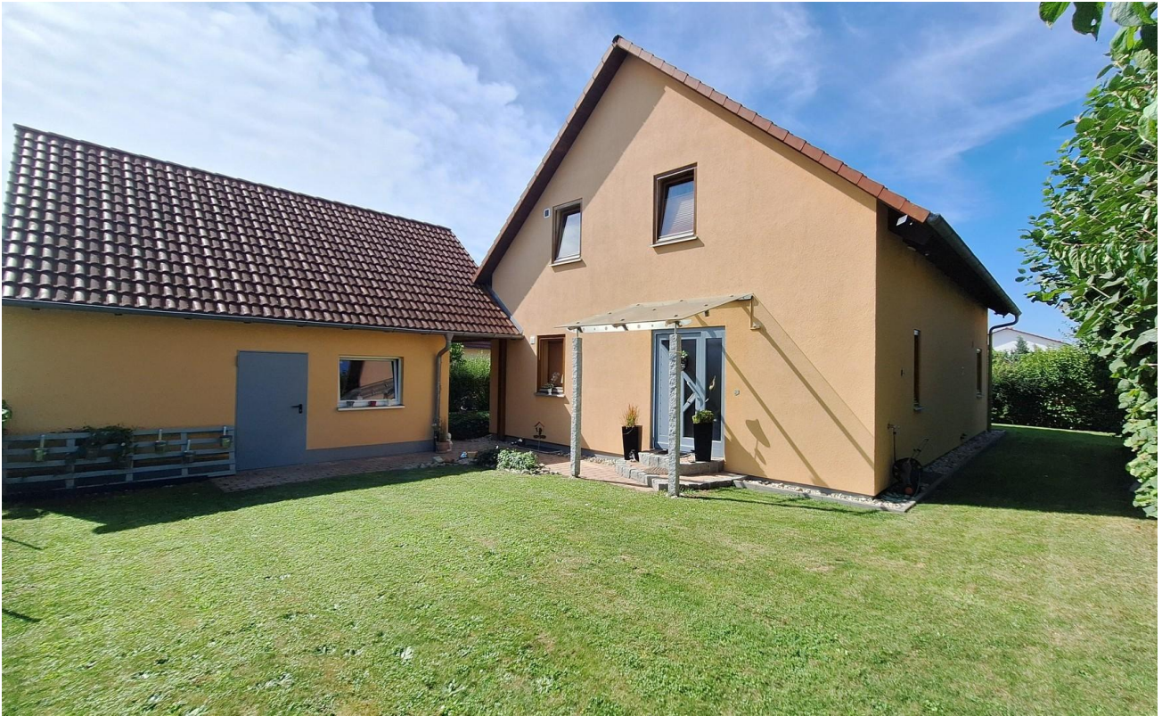
Eingang mit Doppelgarage
