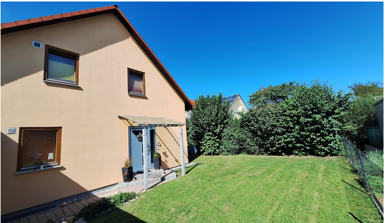
Eingang mit Glasvordach
