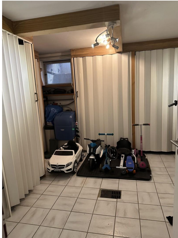
Haustechnik-, Kellerraum UG
