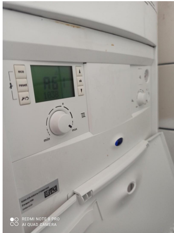
Heizung ganz neu
