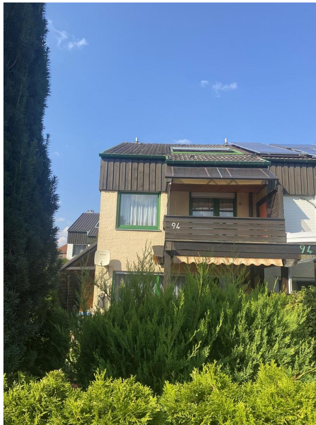
Hausansicht von Straße
