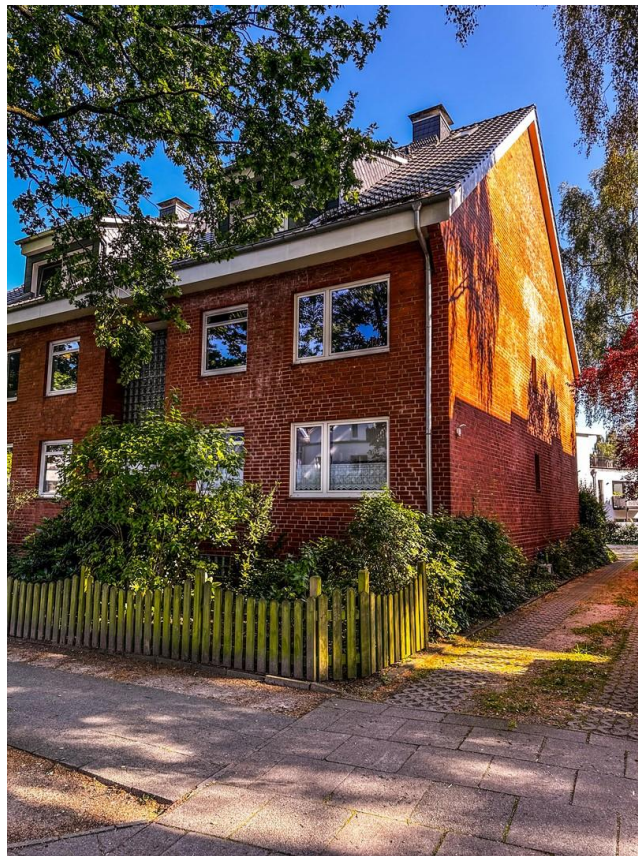
Hausansicht von der Strasse
