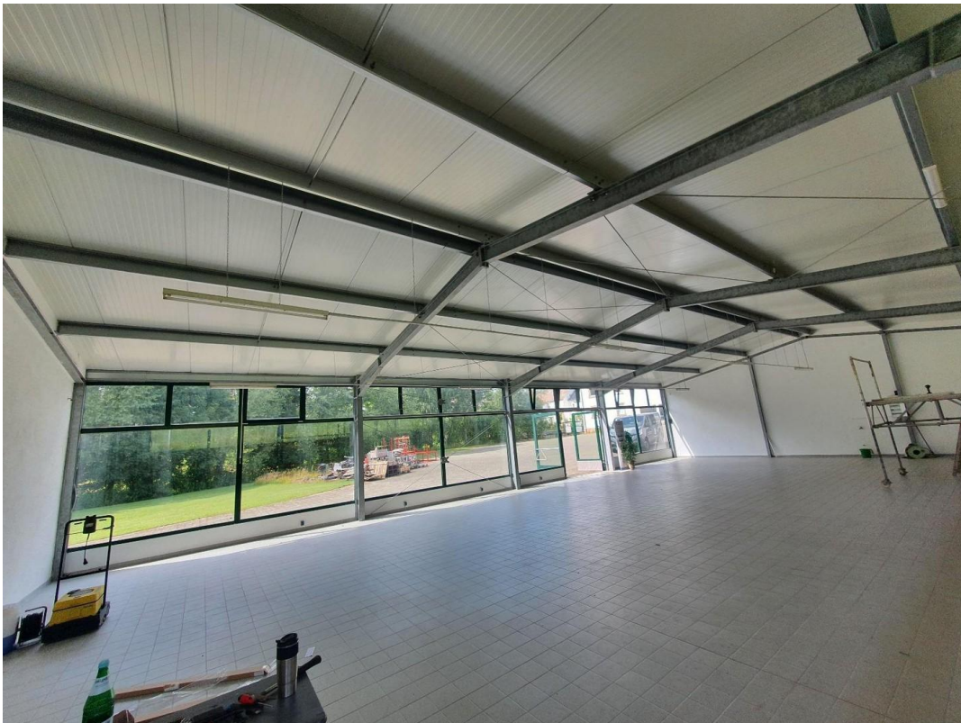
Fensterfront Große Halle
