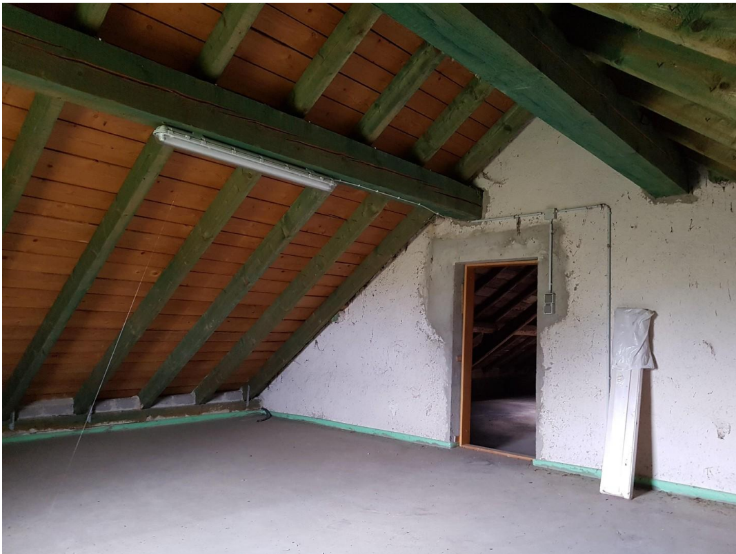
Dachboden des Anbaus
