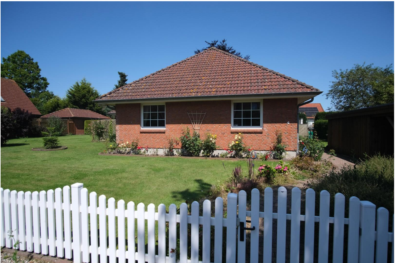
Außenansicht von der Straße
