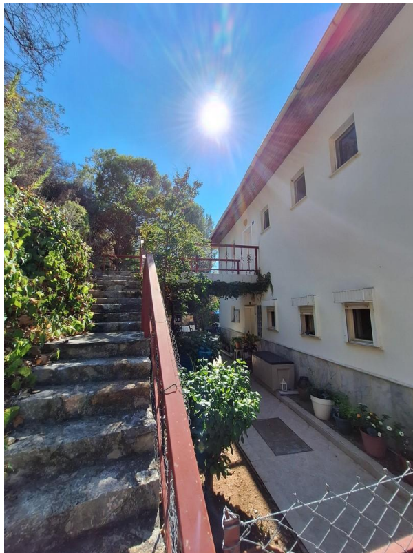
Treppe Wohnung OG
