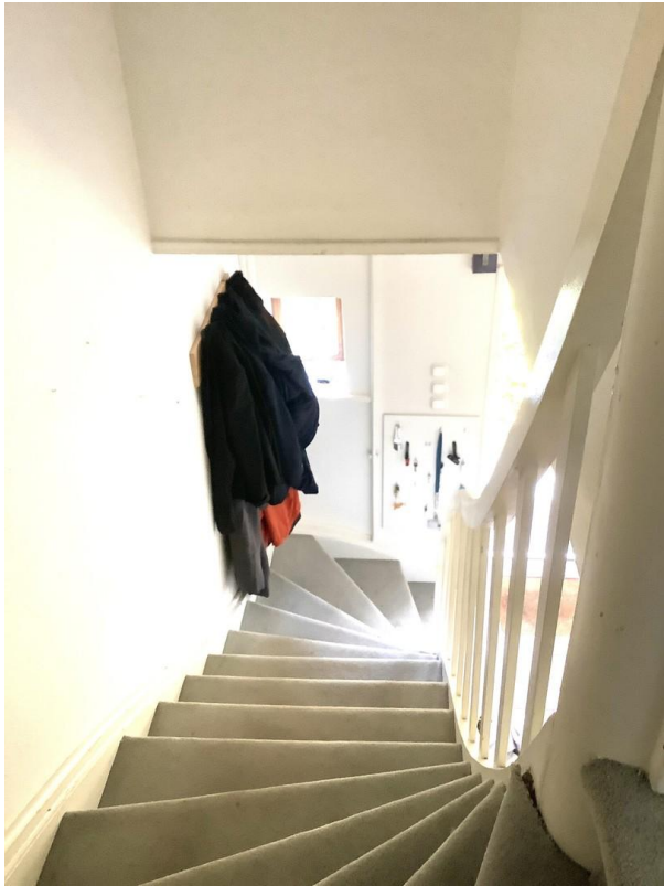
Treppe ins Obergeschoss
