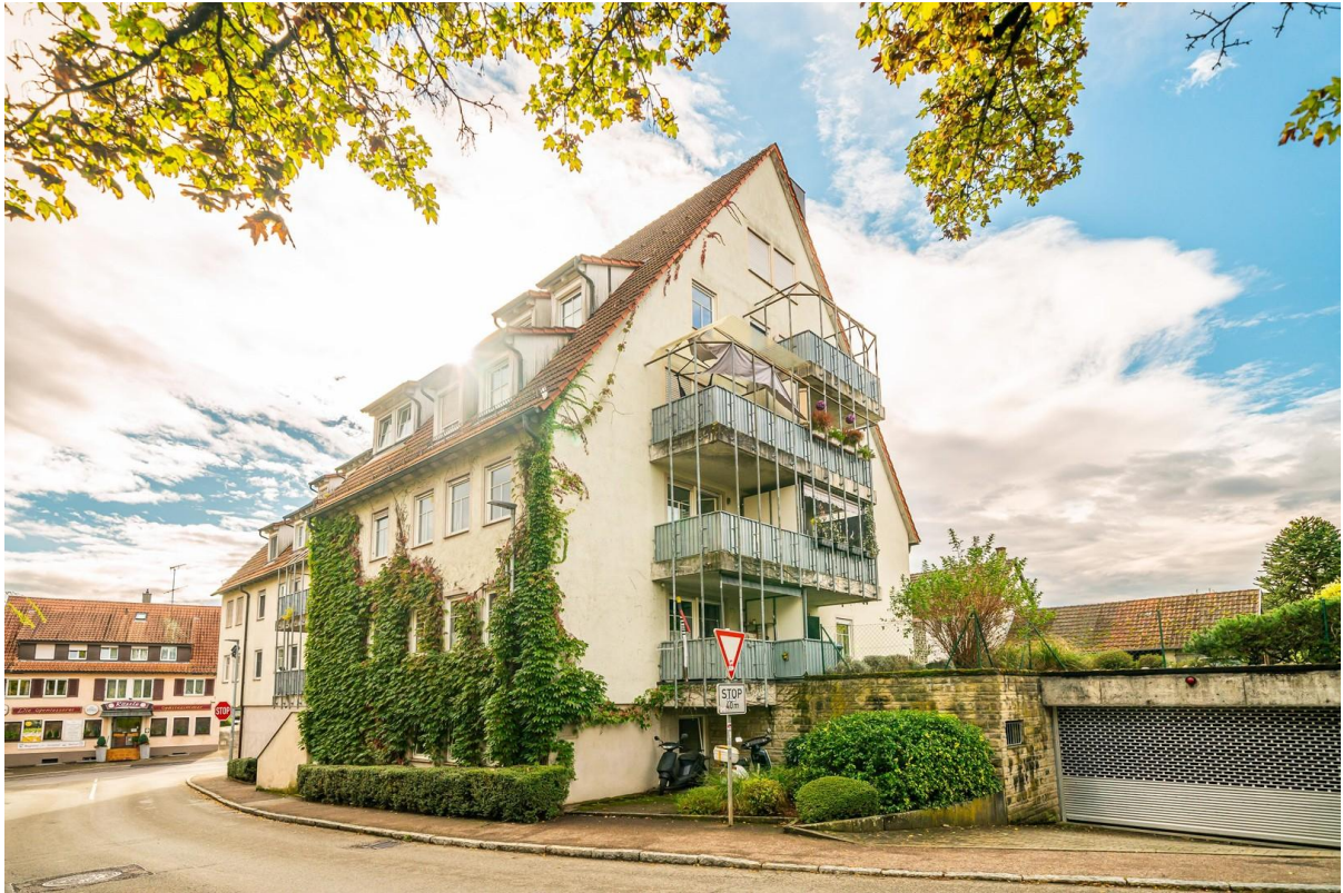
Haus mit TG-Einfahrt
