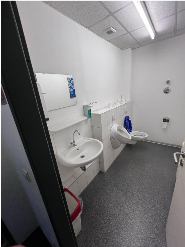
Herren-WC im Erdgeschoss
