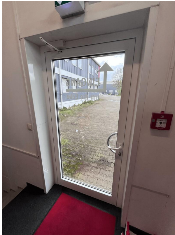
Seitenausgang im Erdgeschoss
