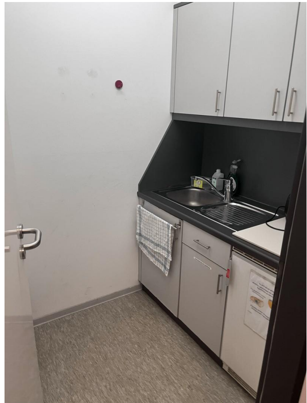
Küche im Erdgeschoss
