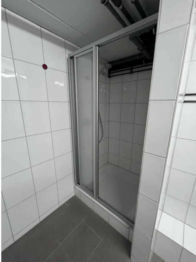
Dusche im Untergeschoss
