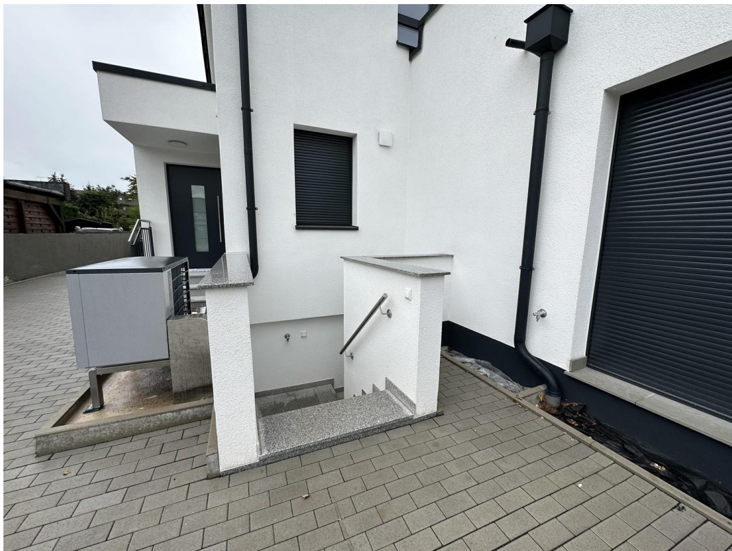
Eingang Waschküche & Kellerr.
