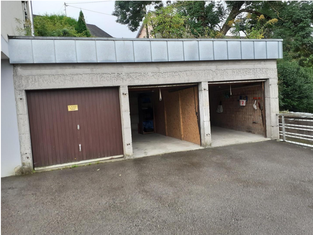
die 2 Garagen mit Stellplatz
