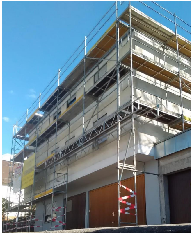
Dach Fassaderneuerung vor 6 J
