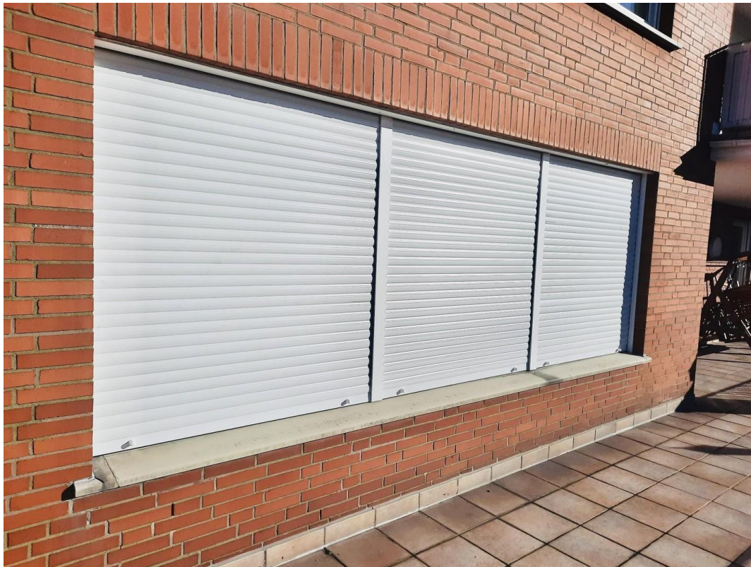
Panoramafenster mit Rollläden
