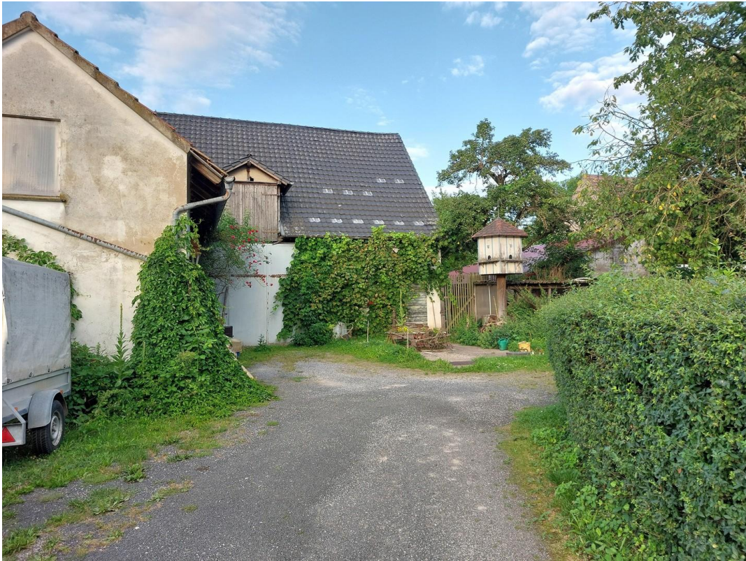
Blick auf Scheune
