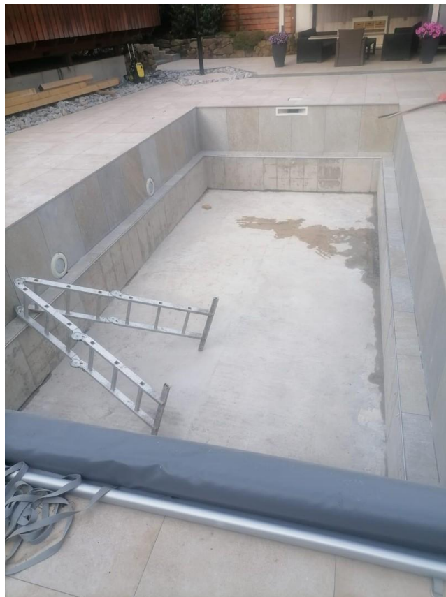
Pool in Fertigstellung
