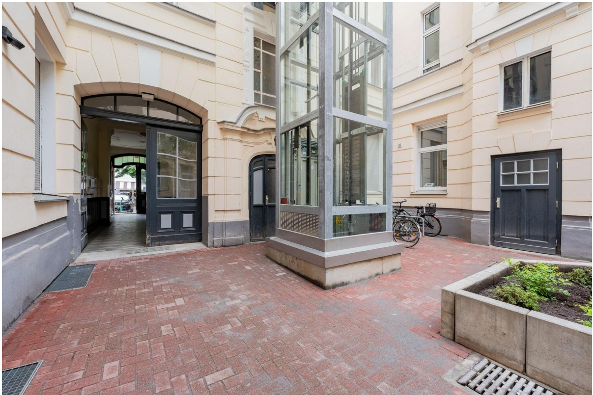
Aufzug Vorderhaus Innenhof
