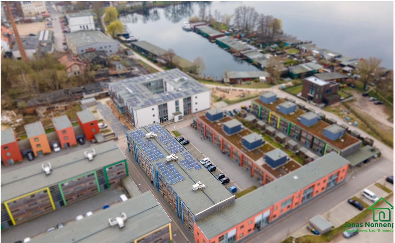
Ansicht nach Südwesten
